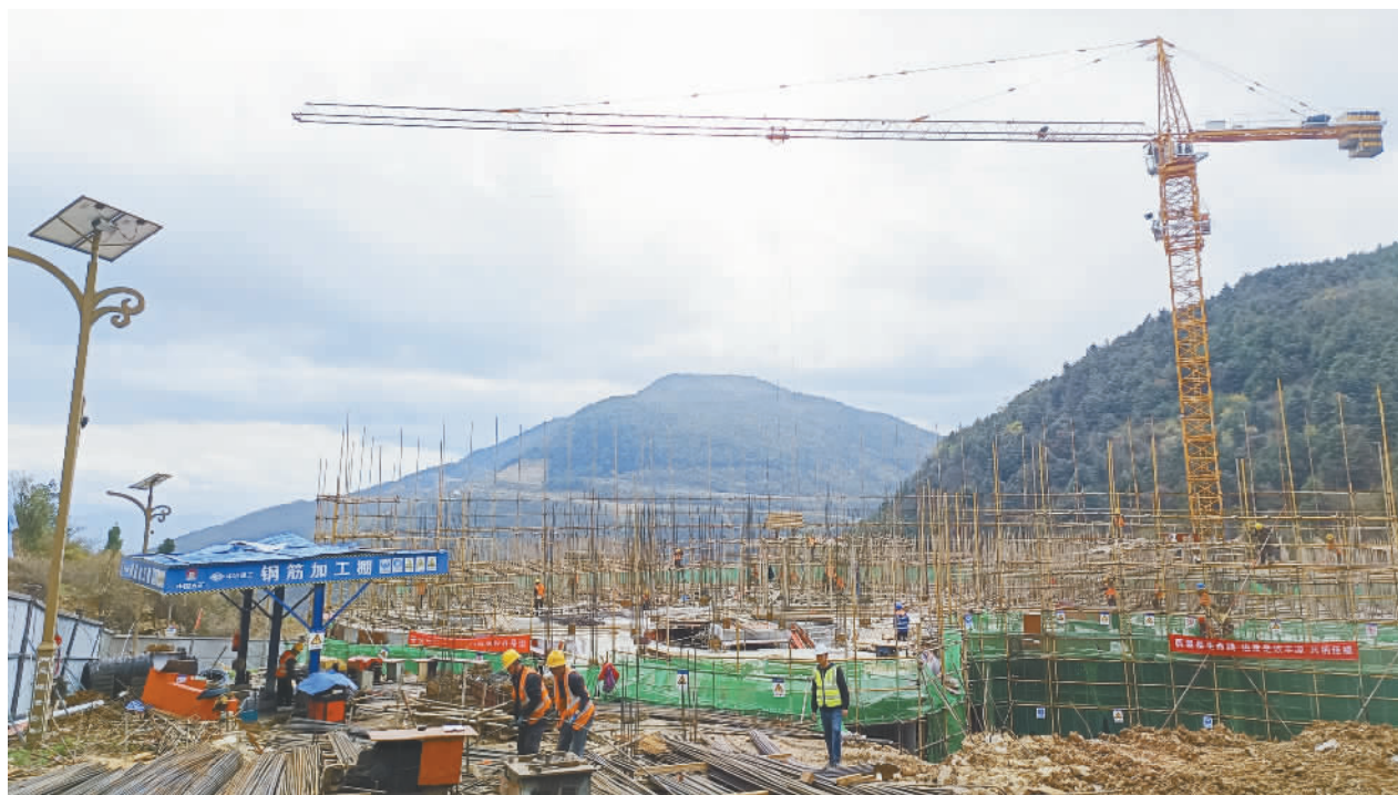
摩天岭森林生态康养运动中心项目建设现场，工人们各司其职，稳步推进项目建设。
