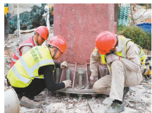
工人正在安装基站底座。
