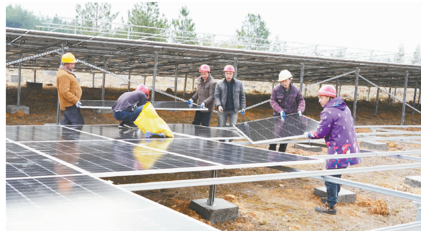
工人正在安装光伏板。
