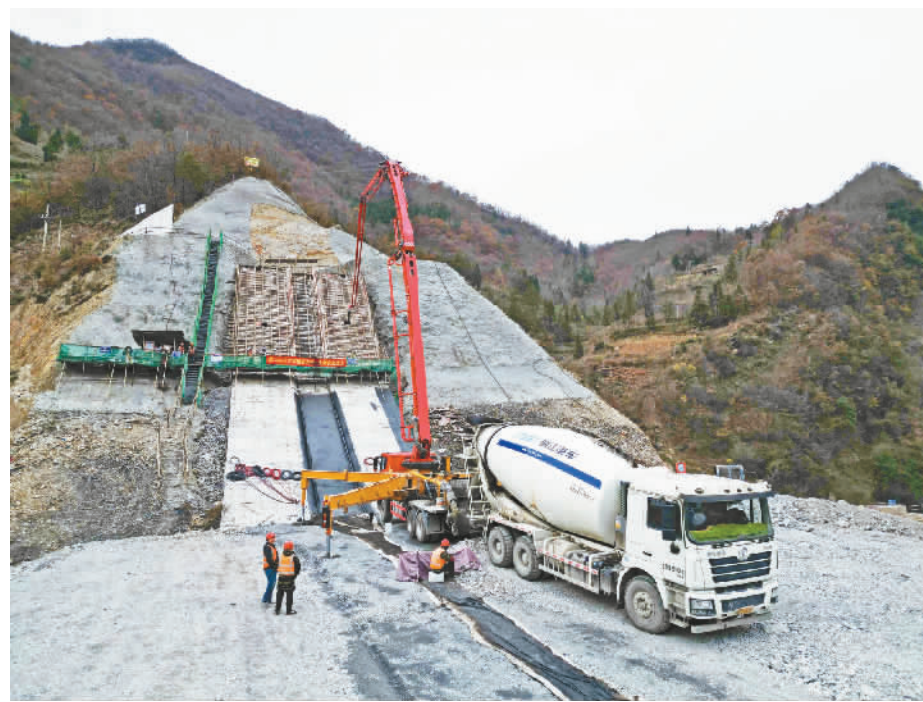
左岸廊道浇筑。
