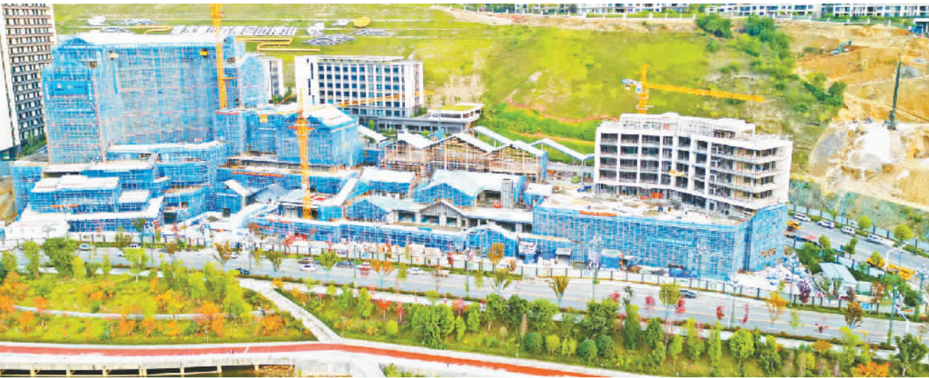
正在建设的龙江新区文化旅游综合服务设施
