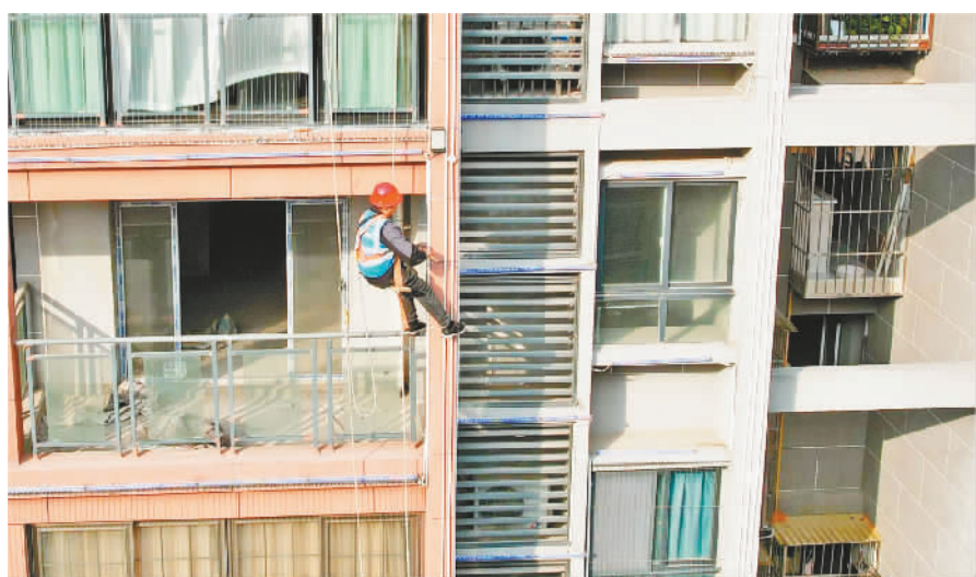
灯饰维修人员正在进行高空作业。
