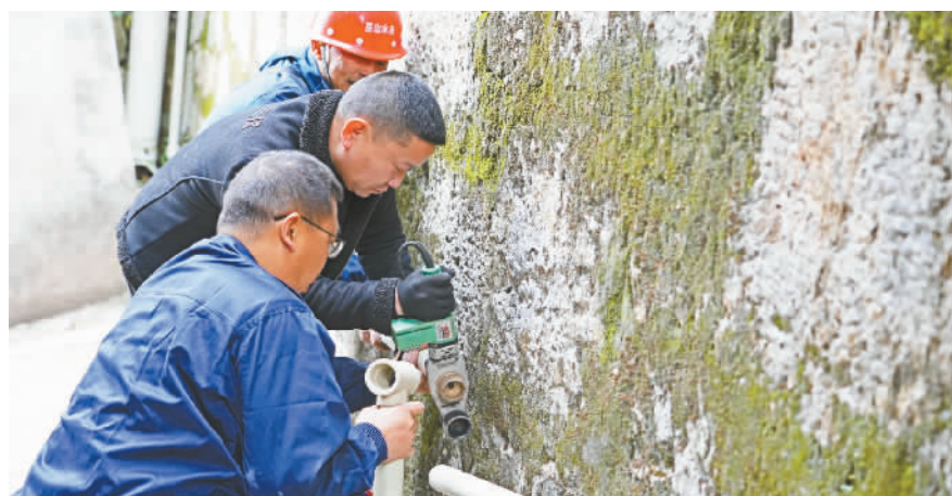
工人焊接水管。
