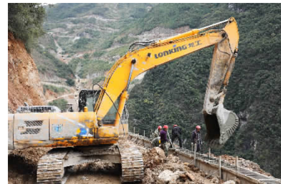
挖掘机正在进行路面施工作业。
