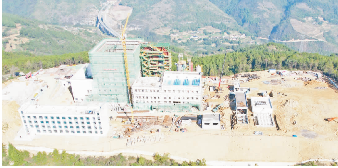
正在建设的巫山县生活垃圾焚烧发电项目。
