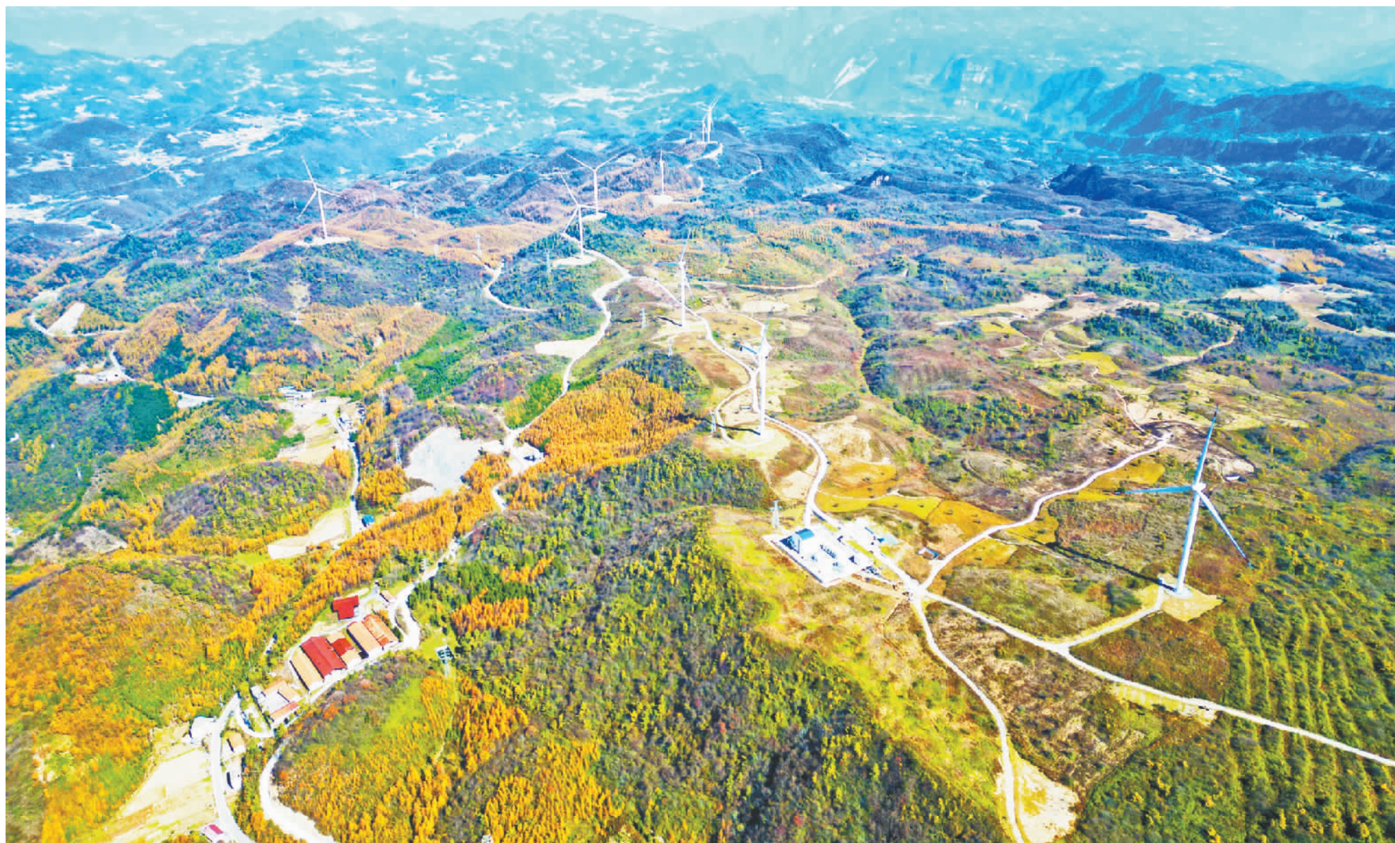
华能巫山红椿风电一期项目。
