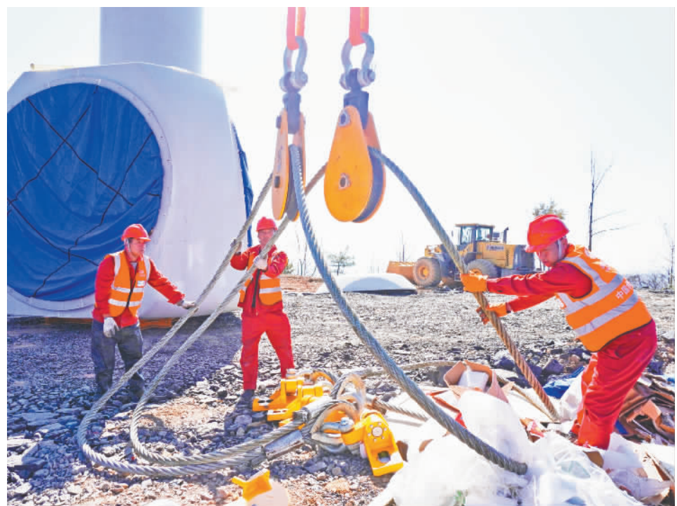
华能巫山红椿风电项目工作人员正在整理吊具钢丝绳。
