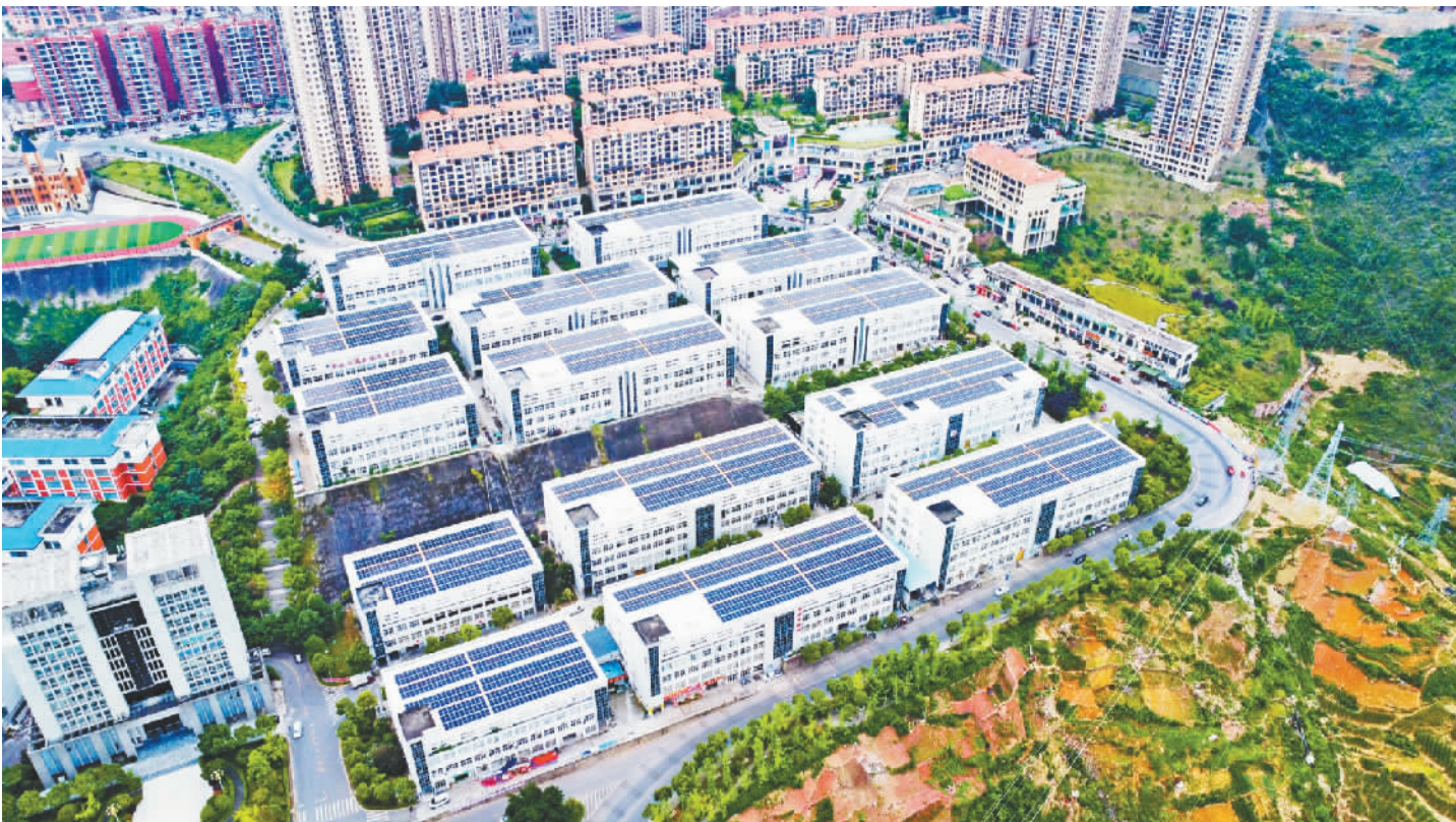
县职教工业园区屋顶分布式光伏项目。
