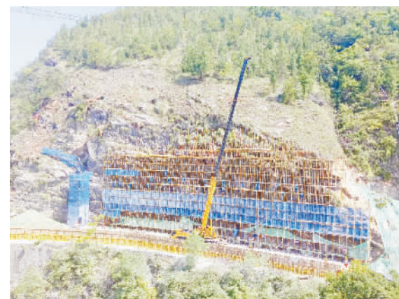
龙门复线桥边坡治理。
