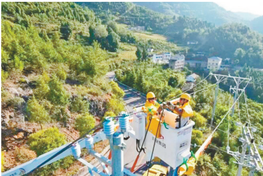
高空作业保障用电。
