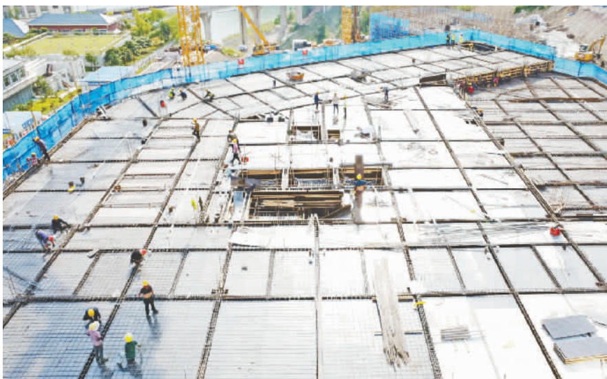
工人正在施工。
