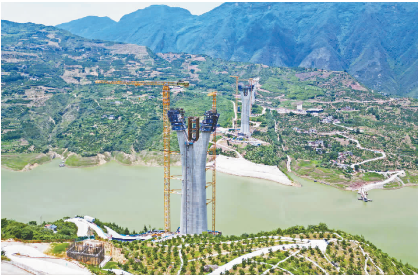
建设中的大溪河特大桥。
