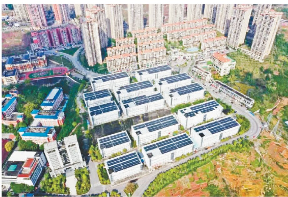
县职教工业园区屋顶光伏项目。
