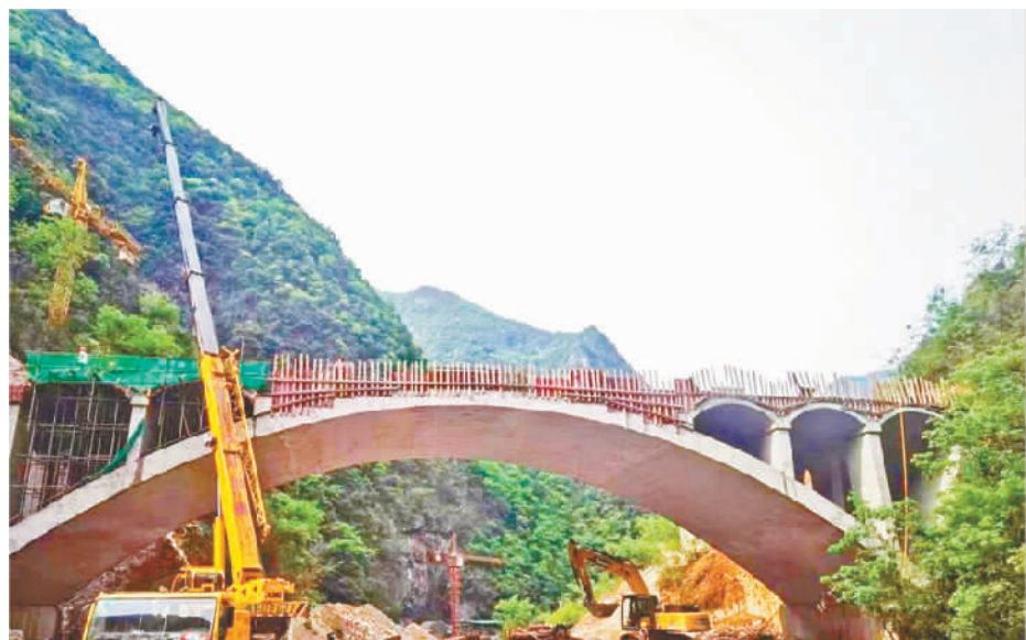
正在建设的后溪河拱桥。
