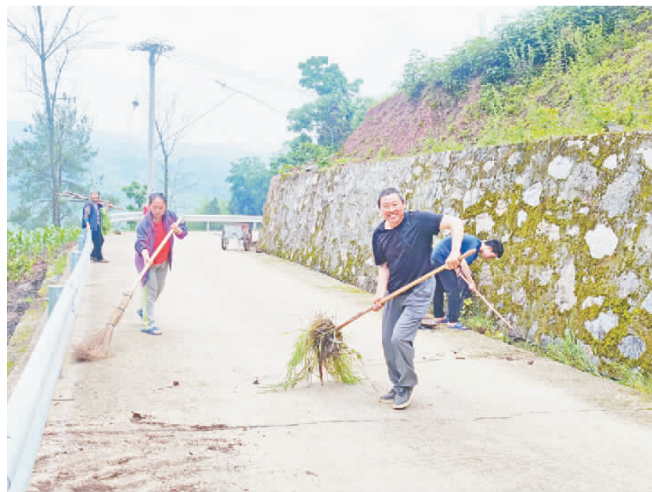
对公路沿线杂草进行清理。
