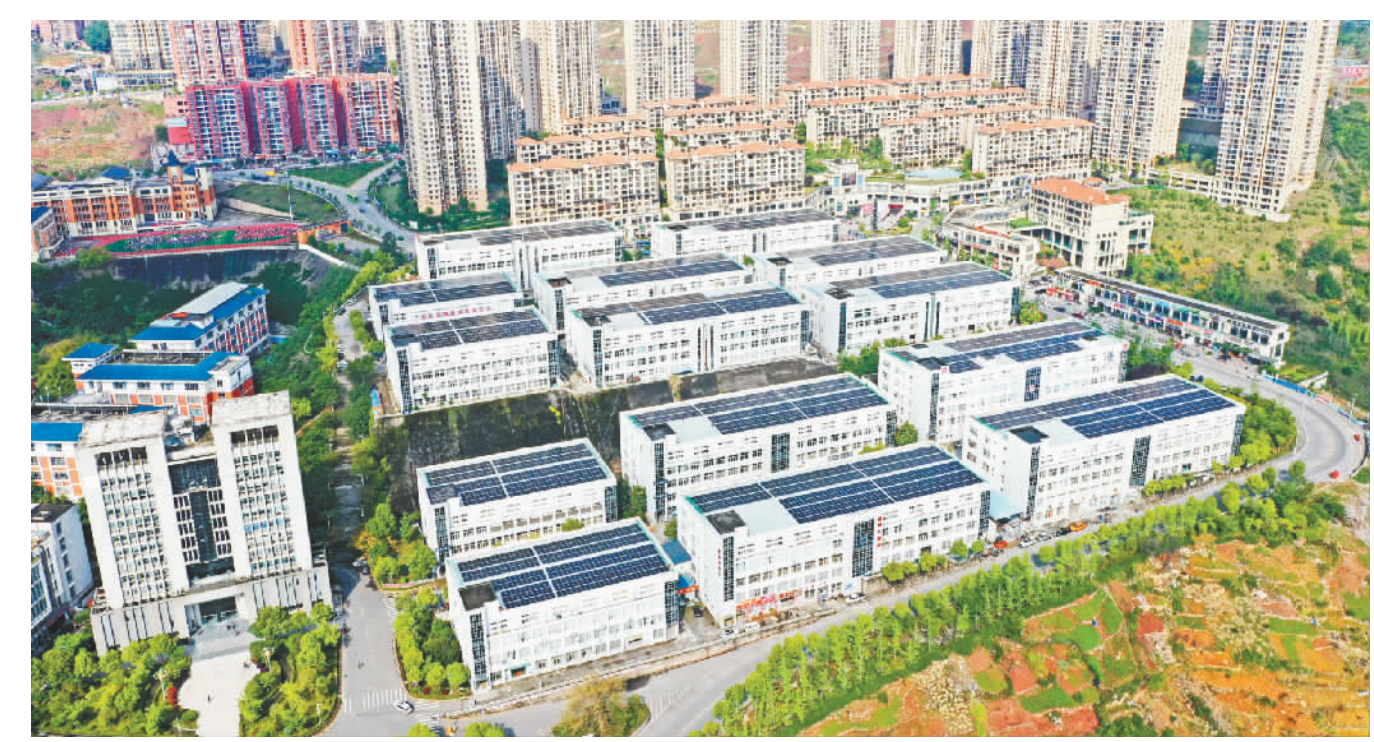
工业园区屋顶光伏项目。
