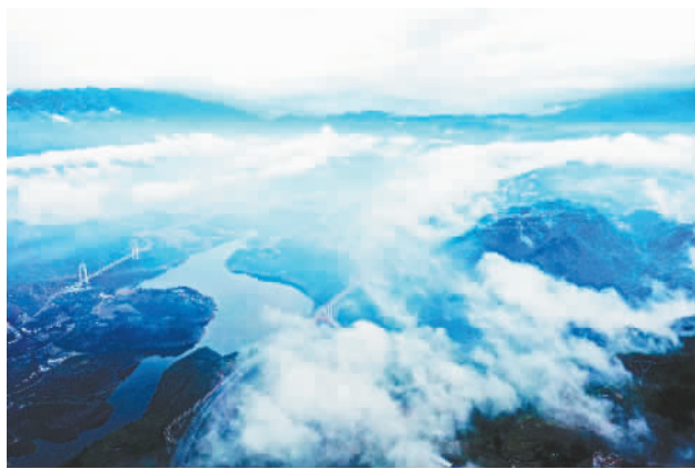
若隐若现的桥梁。
