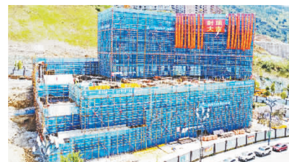
正在建设的1-2#(栋)综合楼。
