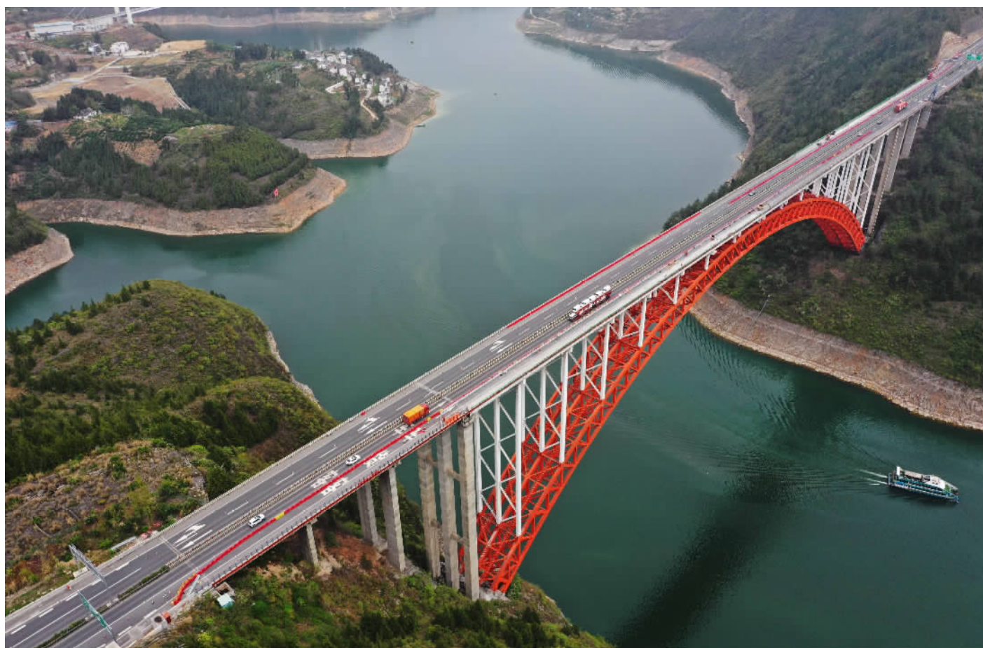
车辆行驶在渝宜高速公路巫山境内的大宁河特大桥上。
