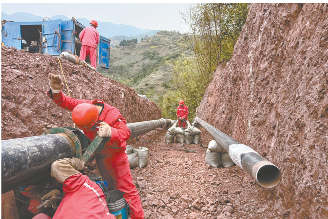
工人铺设管道。
