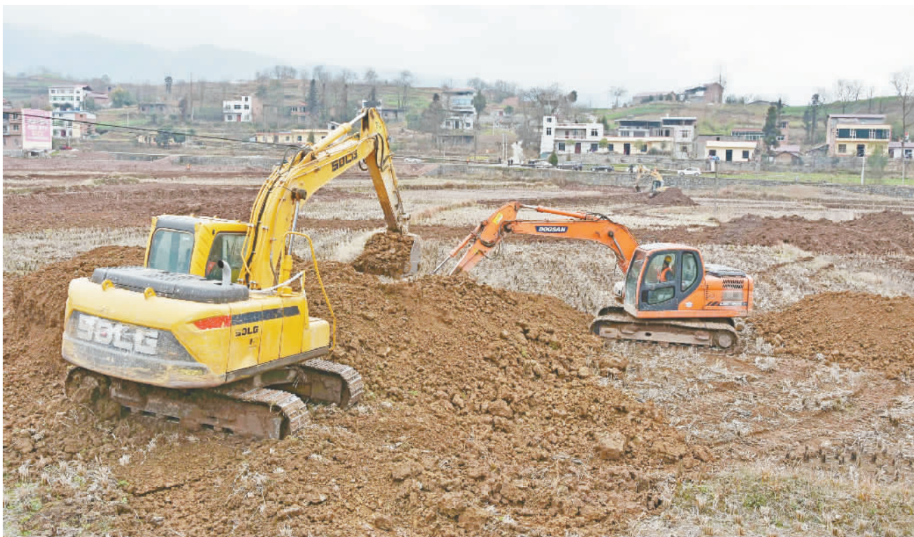
挖掘机开展表土剥离。
