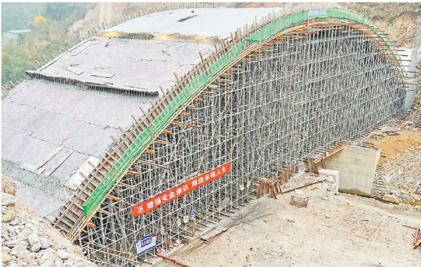
后溪河拱桥主拱圈浇筑完成。
