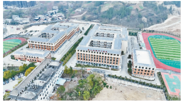
龙江第一幼儿园、龙水中小学已投入使用。
