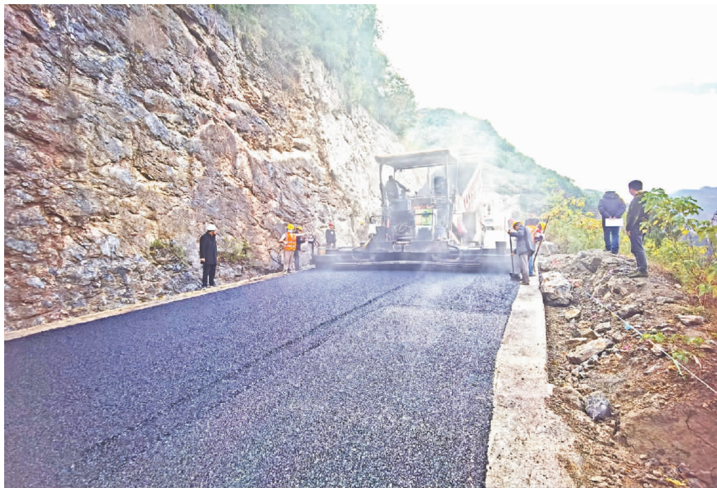
竹平项目沥青摊铺施工现场。
