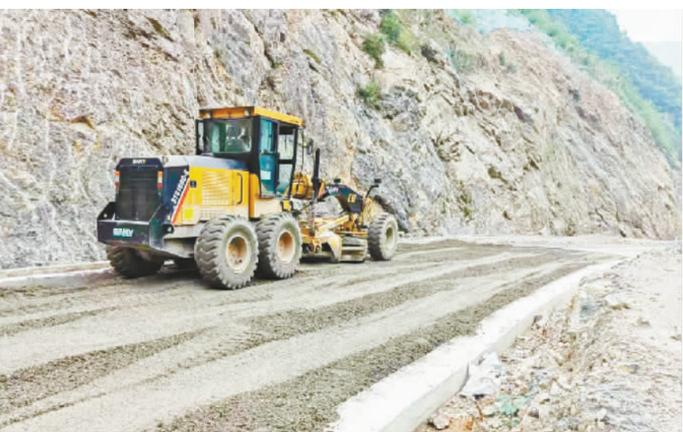
本报讯（记者 王忠虎 文/图）10月5日，竹(贤)平(河)路三标项目开始水稳底基层试验段施工，标志着竹平项目进入路面施工阶段。
