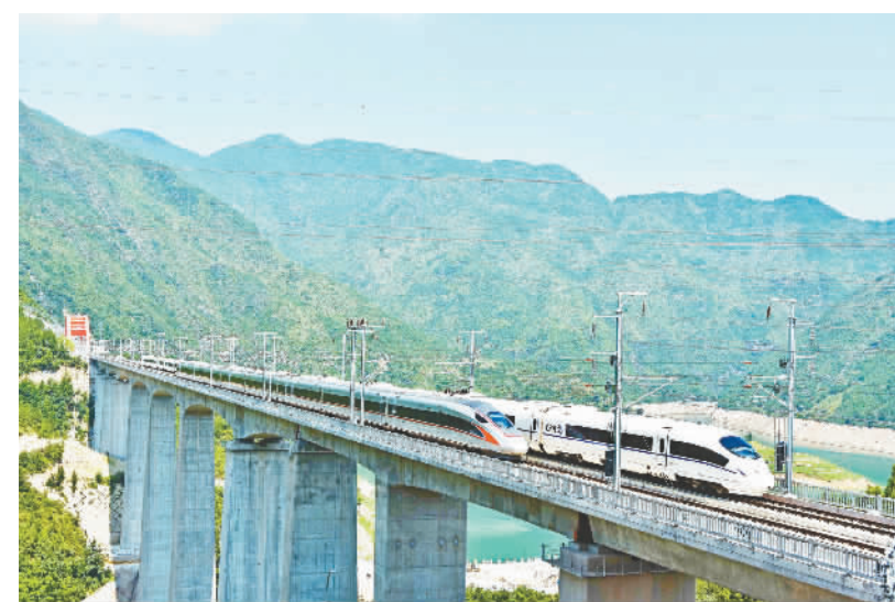
高铁行驶在郑渝高铁巫山段大宁河双线特大桥。
