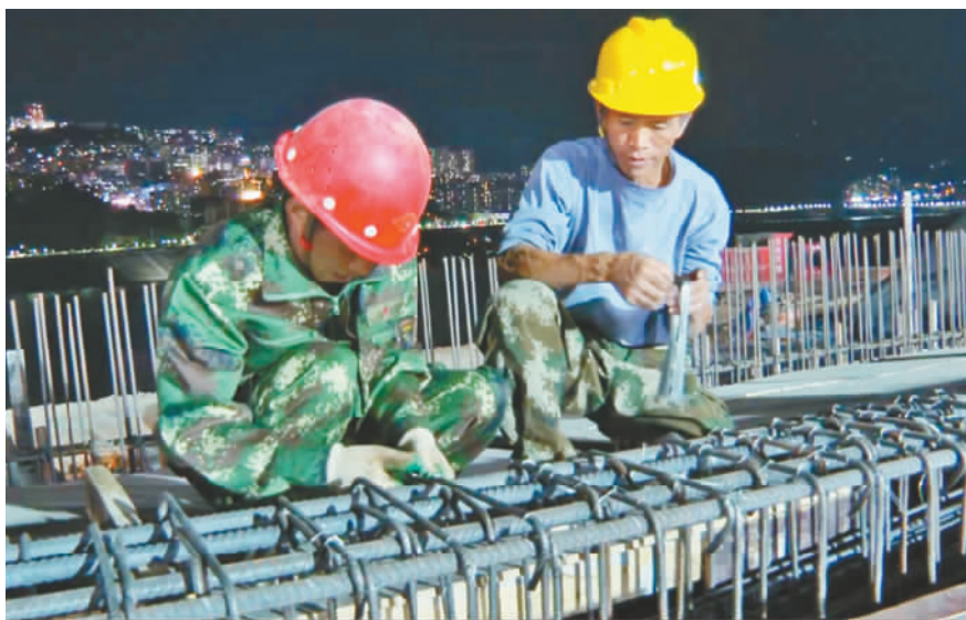
工人们正在绑扎钢筋。
