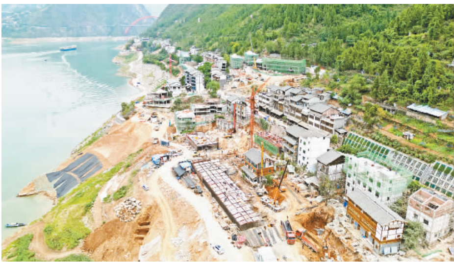
正在加快推进的三峡里·竹枝村项目。
