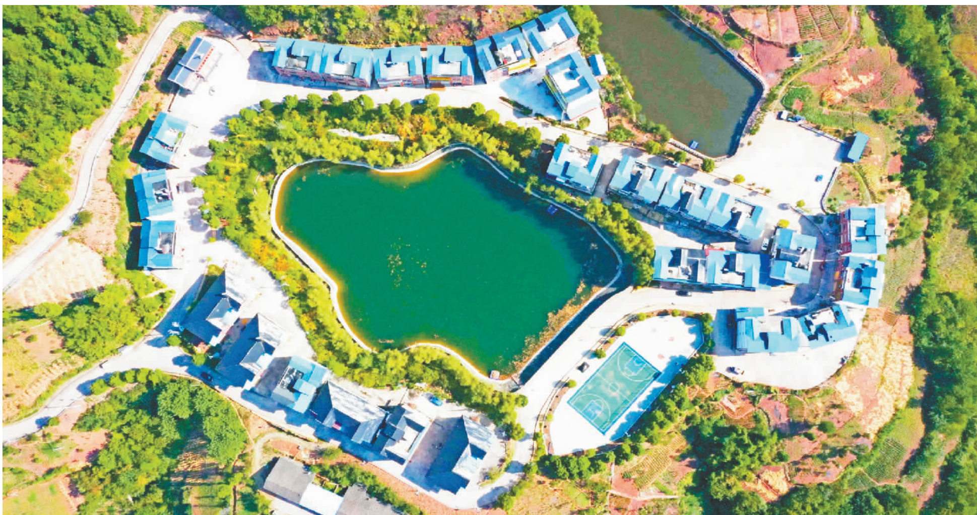
航拍铜鼓镇柳池村集中安置点。
