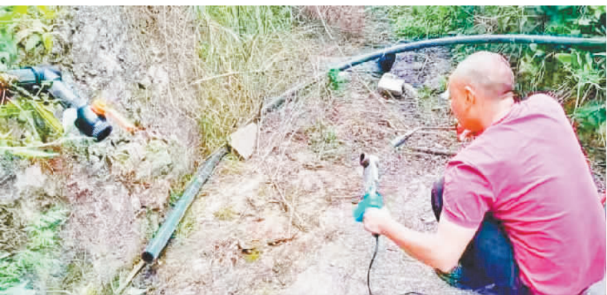
建平乡云台村水管护员正在进行管道维修。
