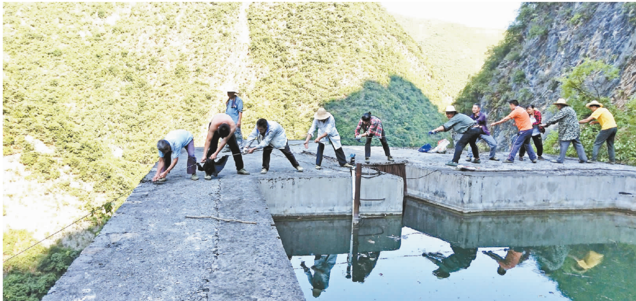
8月12日,曲尺乡曲尺村支部书记李家廷带领党员干部群众20余人,背负水管钢丝,穿越丛林沟涧,攀爬至溪沟上游,干群合力架设应急水管2.3公里,将溪流引入曲尺村、锁龙村,有效缓解人畜饮水和产业灌溉压力。 记者 卢先庆 摄
