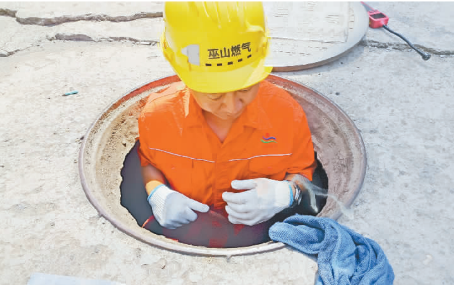
燃气工作人员正在检修阀门。
