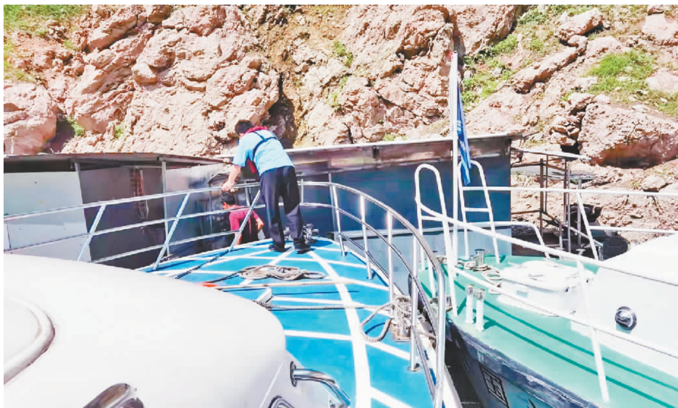
搬离拆除滑钓违法建筑。
