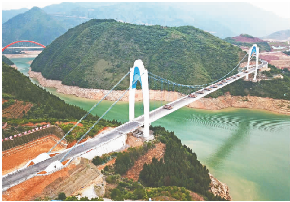
荷载试验现场。
