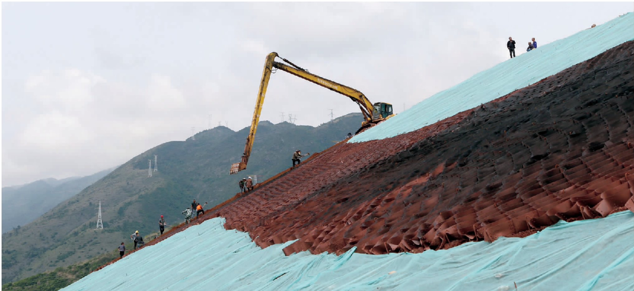
5月1日至5月4日,工人们在桂花大桥两侧进行边坡绿化。记者 卢先庆 摄
