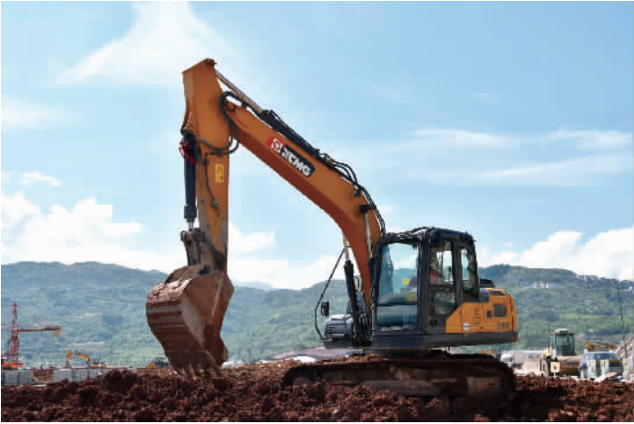
5月4日,高铁驿站绿化带紧张施工。记者 王忠虎 摄
