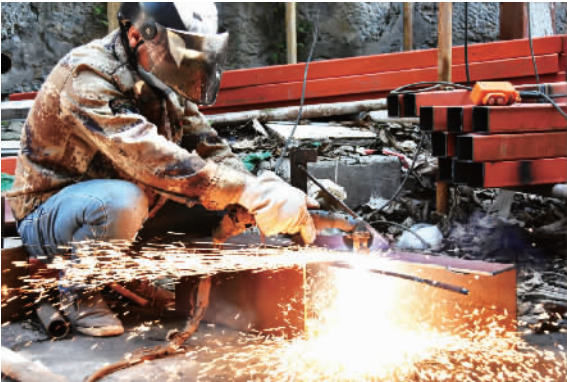
5月3日,高唐街道净坛社区的一老旧小区内,施工人员正在切割钢材为安装电梯做准备。记者 王忠虎 摄
