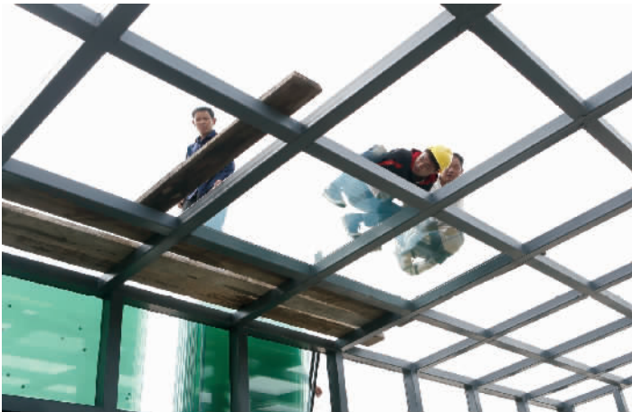
5月1日,建设工人在郑渝高铁巫山站安装透明屋顶。记者 卢先庆 摄
