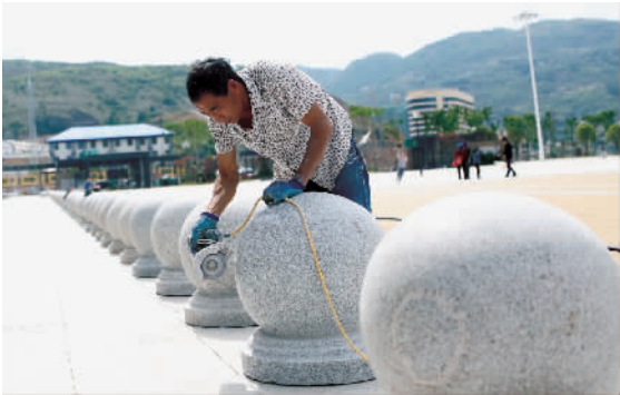
5月1日,在郑渝高铁巫山站,工人正在打磨装饰站前广场石球。记者 卢先庆 摄
