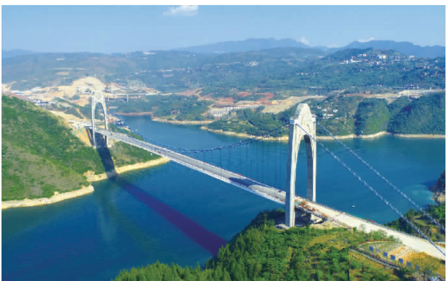
桂花大桥全貌。
