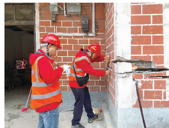
排查墙面裂缝。
