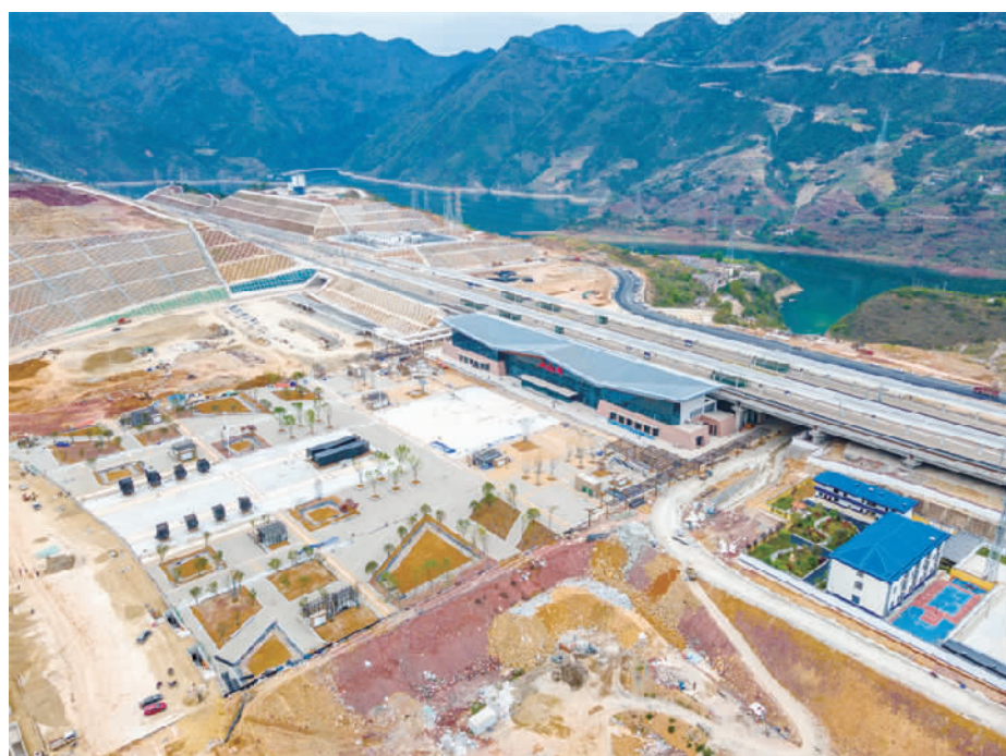
即将竣工的巫山站站前广场。
