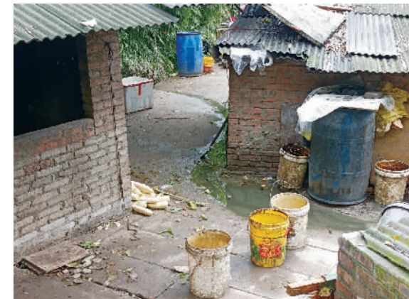
污水乱排乱放。
