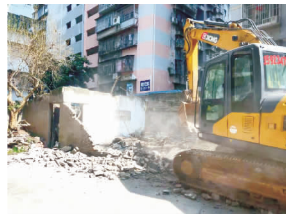
挖掘机正在拆除违章搭建。
