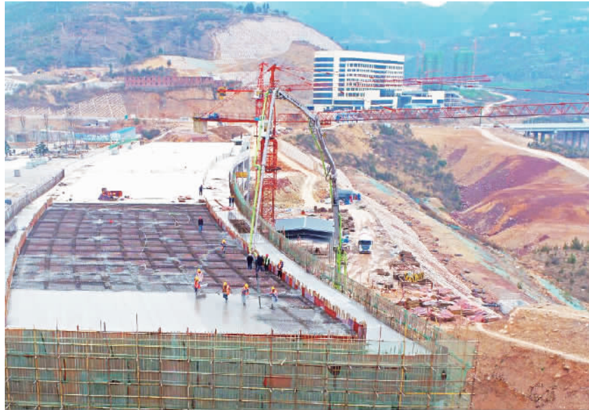
工人正在进行混凝土浇筑。
