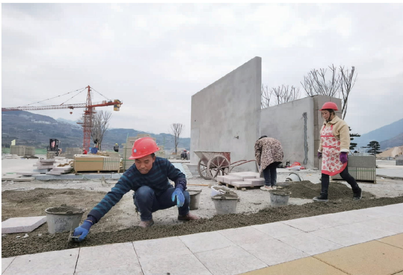
站前广场铺设地砖。
