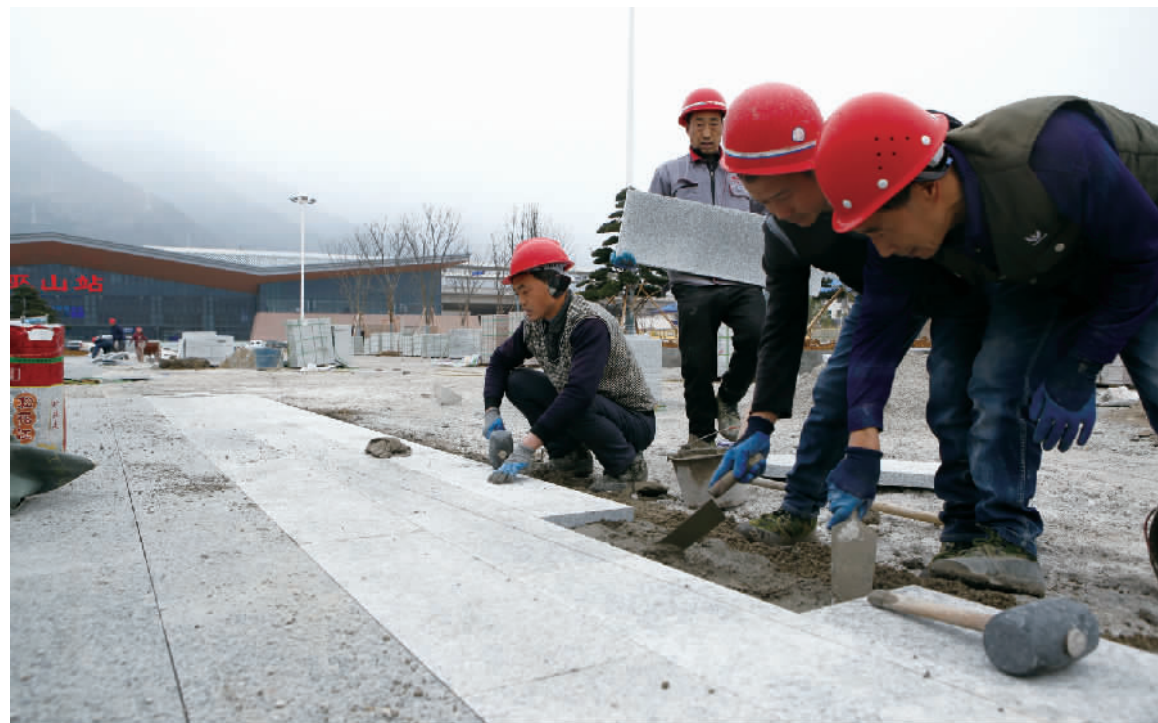
2月8日,工人正在铺设地砖。据了解,郑万高铁巫山站站前广场及基础设施配套建设进度已达91%,预计3月底完工。 记者 卢先庆 摄
