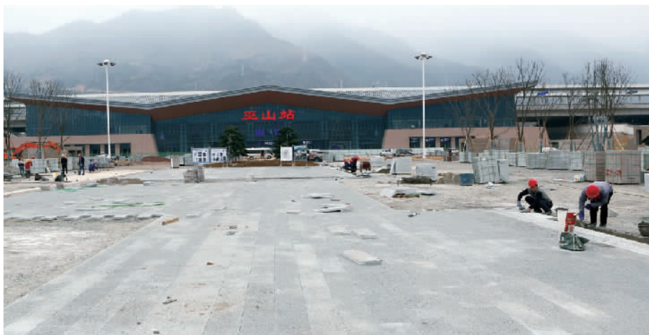
站前广场建设现场。记者 卢先庆 摄
