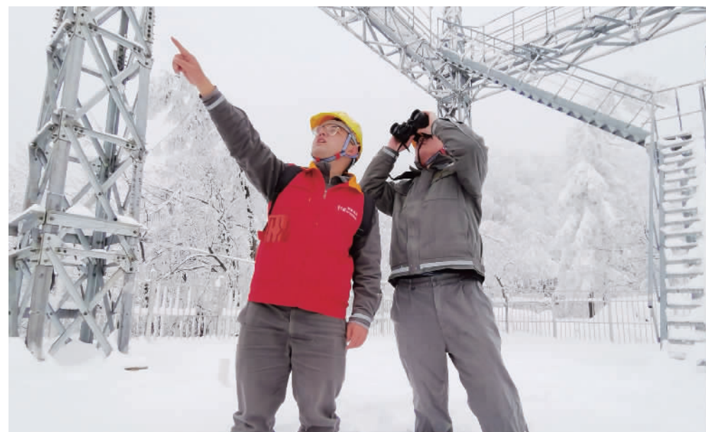
春节期间,电力运检工在雪中用望远镜巡视。记者 王忠虎 摄
