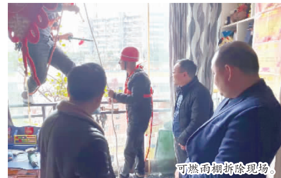
可燃雨棚拆除现场。
