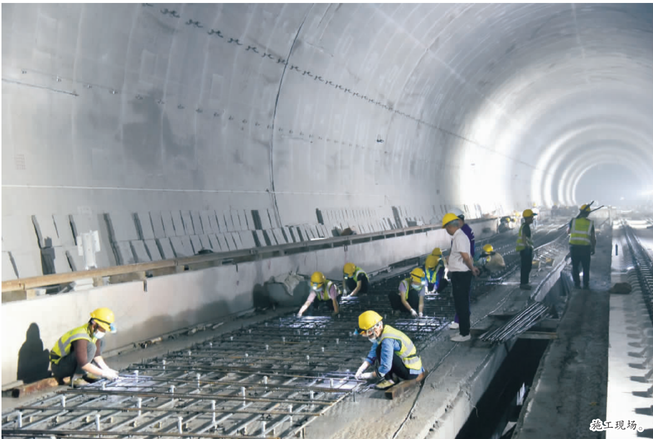
本报讯 (记者 向勇 文/图) 6月18日,记者从郑万高铁巫山指挥部获悉,随着郑万高铁重庆段控制性工程之一的巫山隧道完成无砟道床施工,标志着郑
