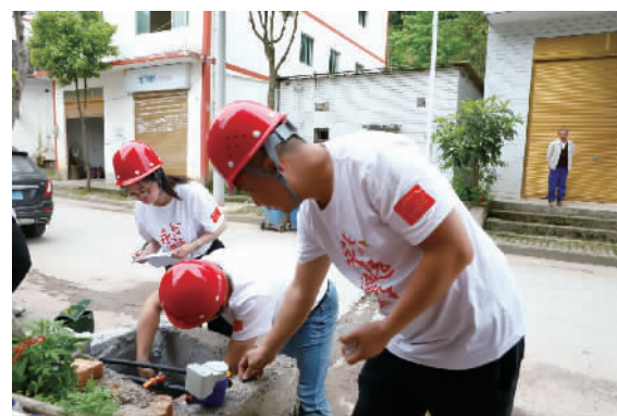
工作人员正在更换水表。
